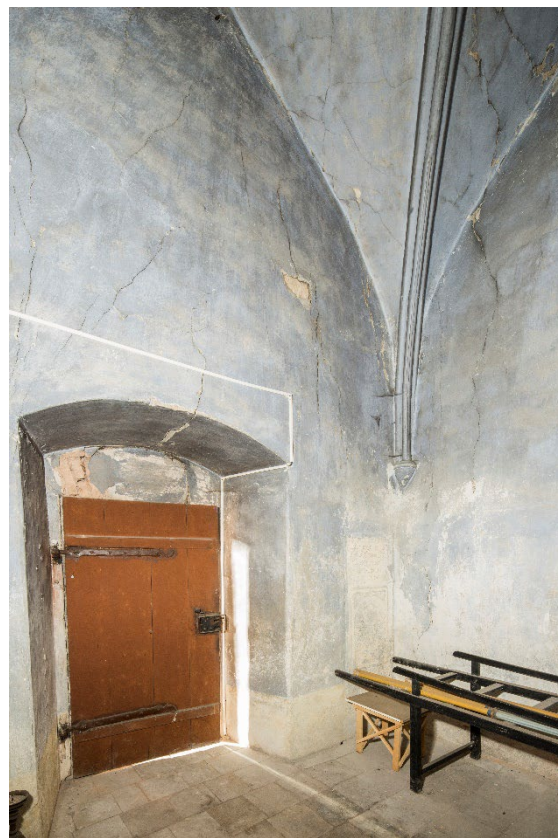
Interiér přízemí věže v pohledu od severovýchodu. Foto: Marta Pavlíková, 2018.
