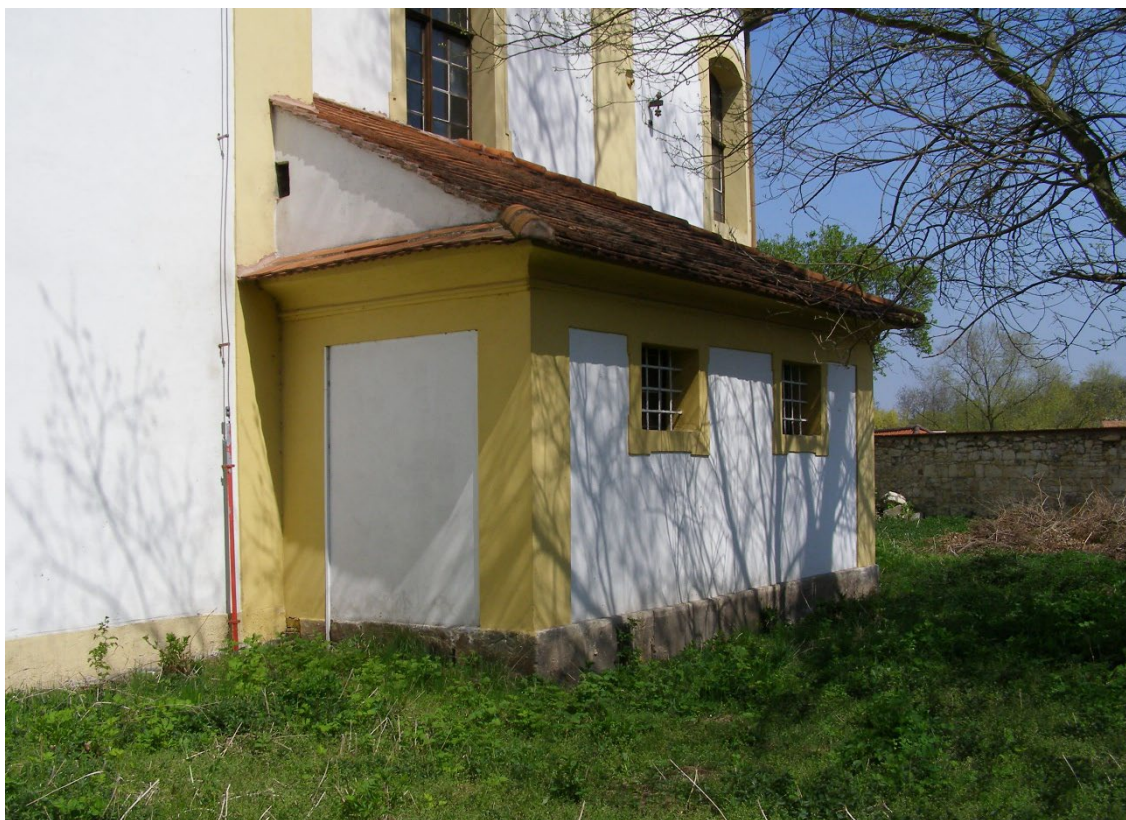
Sakristie v pohledu od jihozápadu. Foto: Jan Koloc, 2010.
