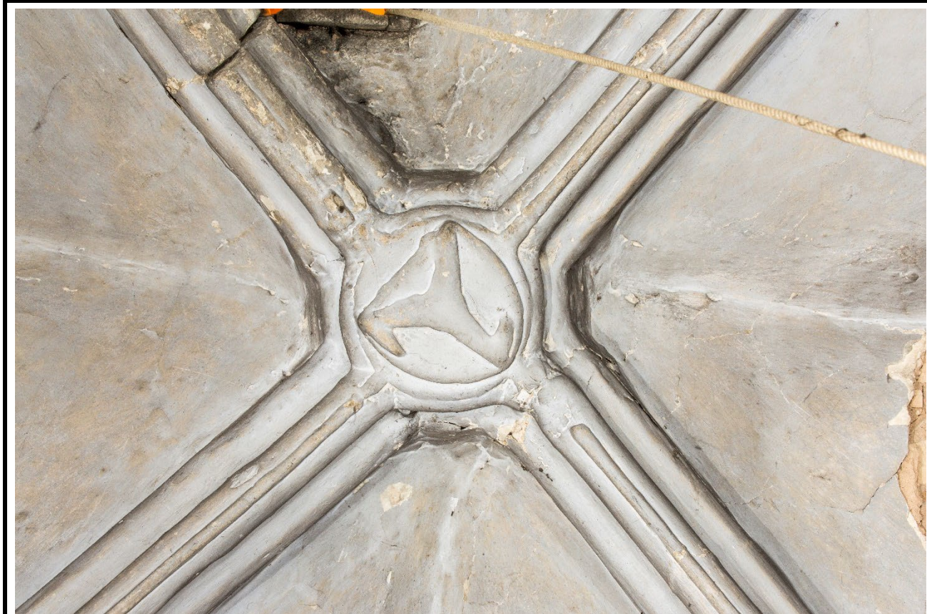
Detail svorníku klenby přízemí věže v podhledu. Foto: Marta Pavlíková, 2018.
