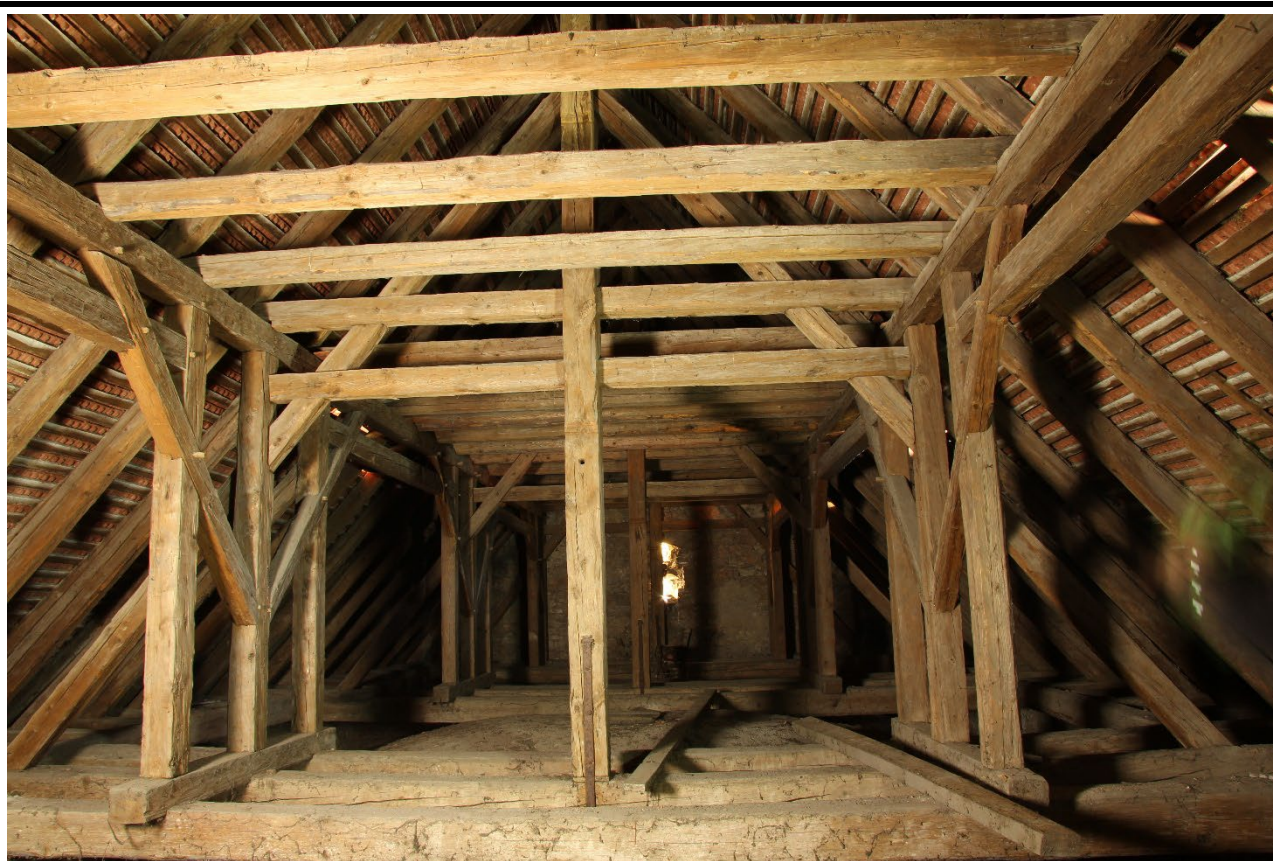
Krov nad lodí v pohledu od východu směrem k západnímu štítu. Foto: Jaroslav Skopec, 2018.
