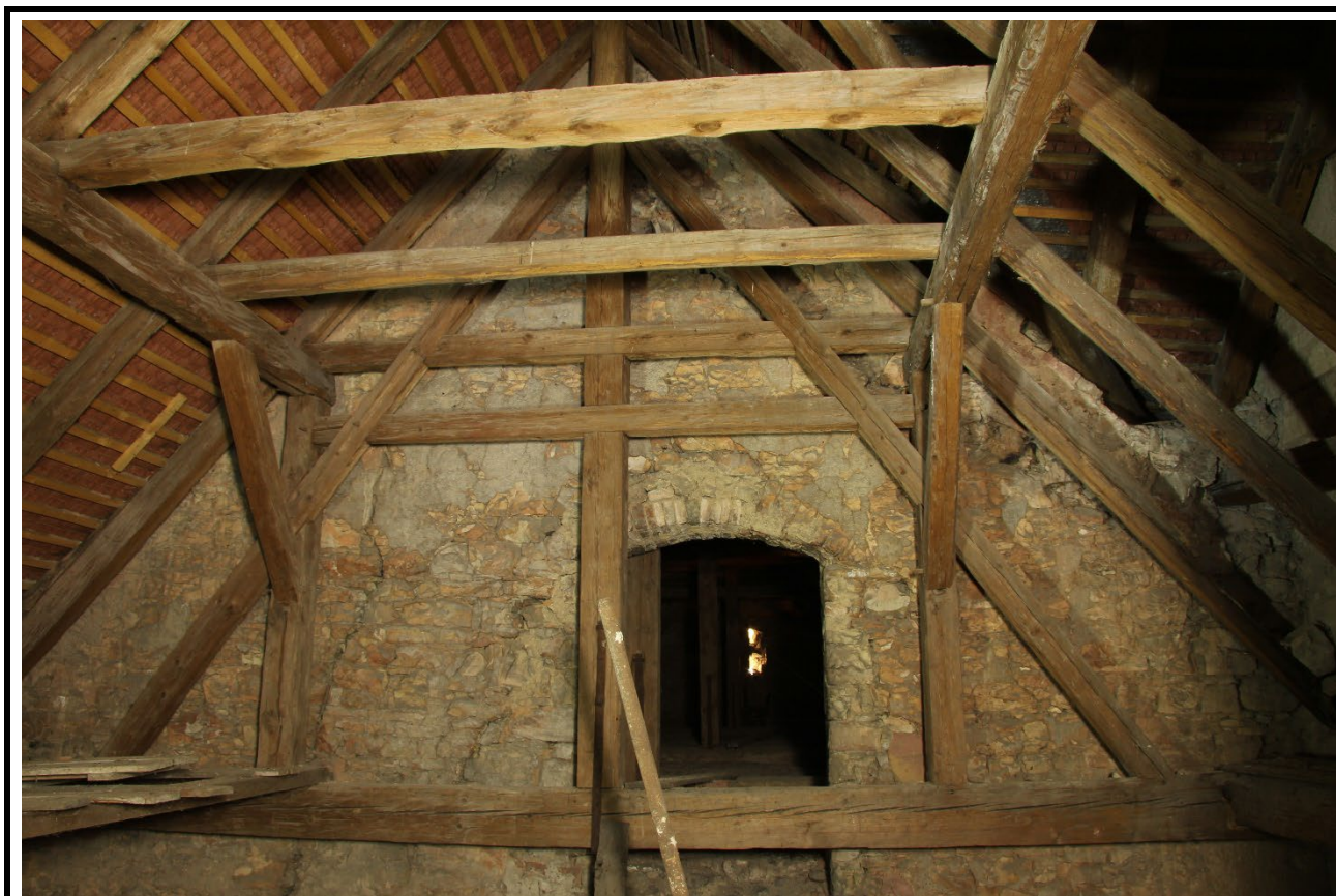
Krov nad presbytářem v pohledu od východu směrem ke štítu mezi presbytářem a lodí. Foto: Jaroslav Skopec, 2018.
