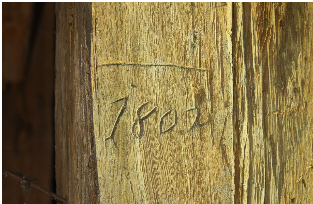
Detail datace vytesané na věšadlovém sloupku 3 plné příčné vazby krovu nad lodí od západu. Foto: Jaroslav Skopec, 2018.
