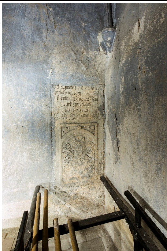
Pohled od severu na náhrobník Jana Illburka a Šebestiána z Vřesovic z let 1567-96 osazeného v jižní stěně přízemí věže. Foto: Marta Pavlíková, 2018.
