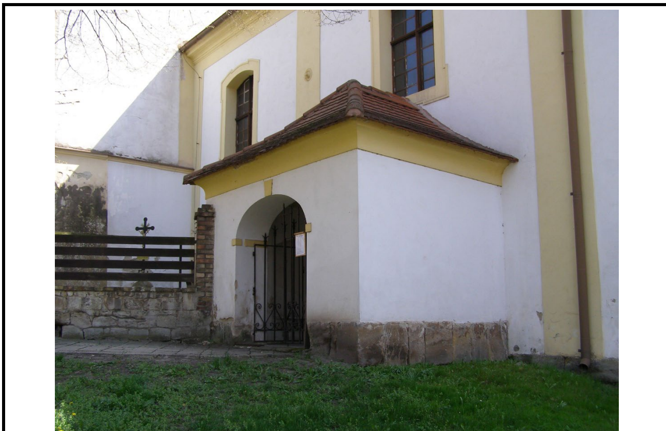
Předsíň v pohledu od severozápadu. Foto: Jan Koloc, 2010.
